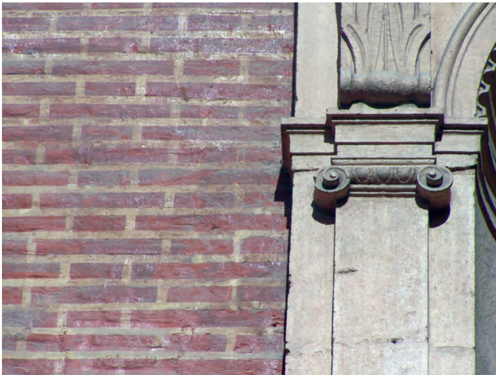
Fig. 10. Detalle de revoco fingido, emulando aparejo en ladrillos, para fábricas del s. XVIII; alzado del Palacio de la Aduana, Valencia. Los ladrillos en este caso son gruesos pero anaranjados, por esta razón se suelen enlucir. El tipo de aparejo es regular, con llagas y tendeles medio-finos (CRISTINI)
