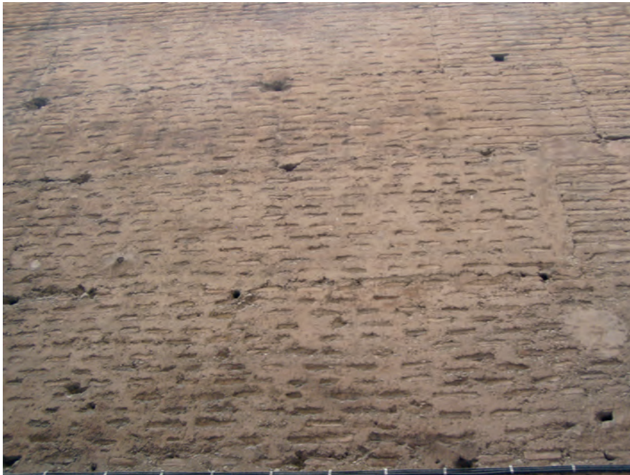
Fig. 1. Detalle de muro de tapia valenciana, fábricas del Convento del Pilar, Valencia (CRISTINI)
