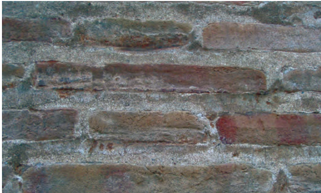
Fig. 11. Detalle de fábricas de cara a vista, alzado del edificio de viviendas en Calle Roger de Flor 36, Valencia. Los ladrillos empleados suelen ser pardos, con grueso marcado, y llagas y tendeles reducidos (CRISTINI)
