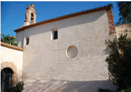
Figure 4. Whitewashed surface of tapia valenciana wall, Ermita de S. Jaume de Fadrell , Castellón (Authors: Cristini & Ruiz Checa).
